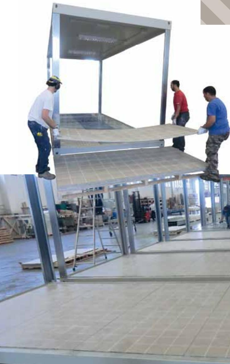
*La tecnologia e materiali utilizzati nel processo di produzione del pannello **MP**TILE fanno sì che lo stesso possa essere montato su strutture altamente deformabili come container e strutture mobili prefabbricate, il nostro prodotto ha ottenuto eccellenti performance anche nei casi dove le strutture di cui sopra debbano essere trasportate dalla fabbrica ai cantieri di destinazione.*
